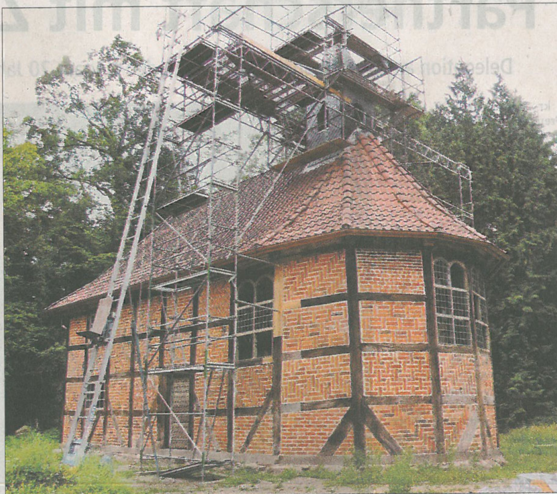
Für die Renovierung des Glockenturmes war der Aufbau eines Spezialgerüsts erforderlich. Bis zur Einweihung ist es abgebaut. Fotos: cb
